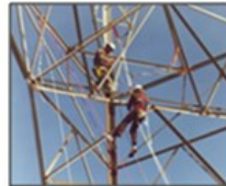
Flare / Telecom IRM
