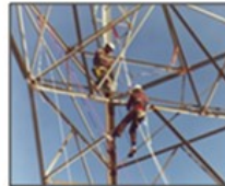
Flare / Telecom IRM
